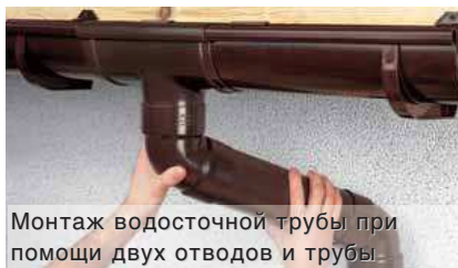
Монтаж водосточных труб
