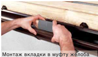
Монтаж вкладки в муфту желоба
