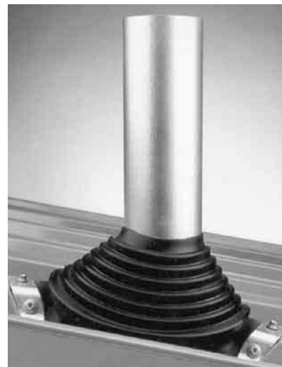
Рис. 18 Обробка для вентиляційних виходів (Master Flash)
