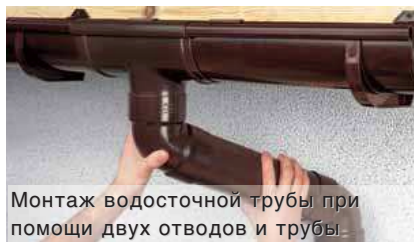
Монтаж водосточных труб
