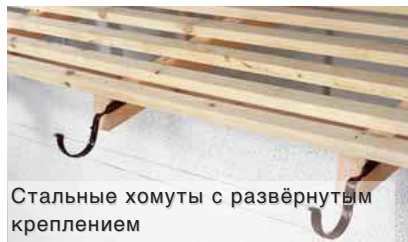
Регулируемые стальные крепления
